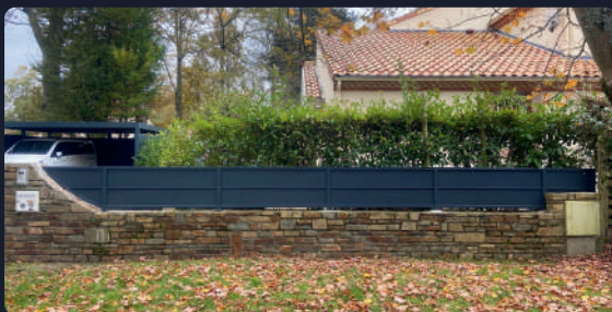
Clôture avec suivit de maçonnerie Carnac Gris 7016
